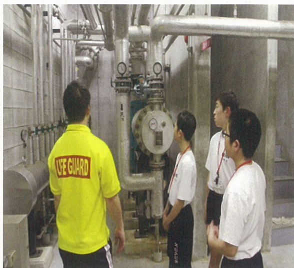
屋内プール機械室見学
