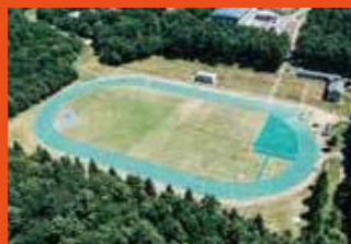
蔵王グリーングラウンド (全天候型グラウンド 8 レーン)
